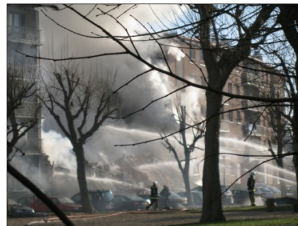
Noisy-le-Sec (93) le 22/12/2007 Effondrement d'un immeuble
